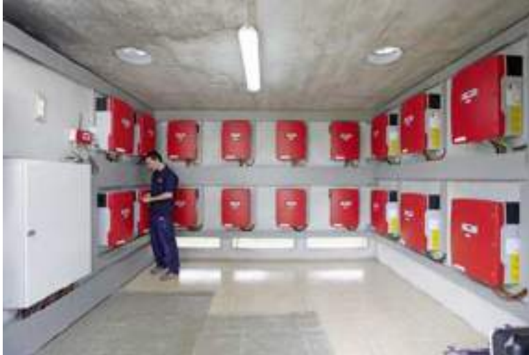
Imagen 6. Ejemplo de instalación de inversores distribuidos
